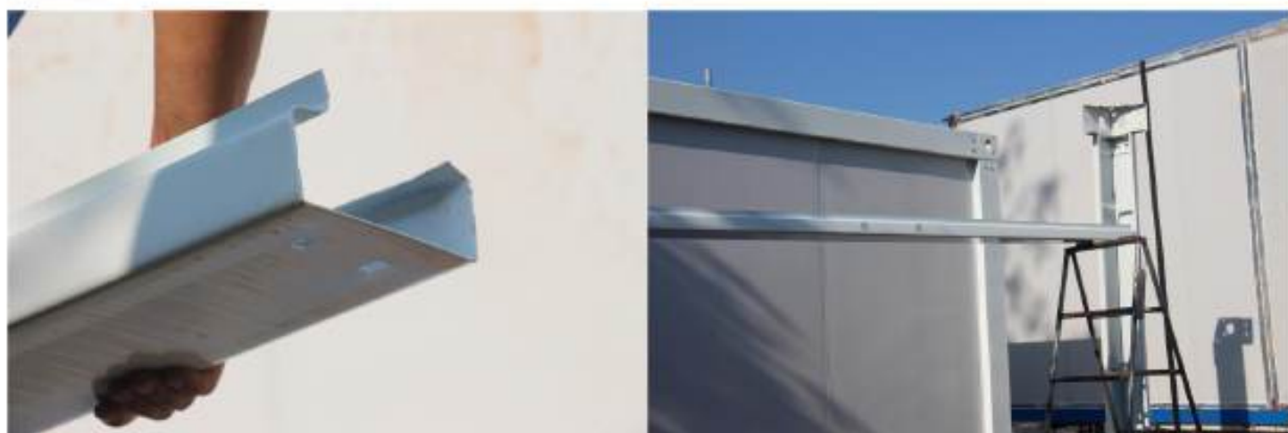
10、准备 4 个顶部框架安装，为方便安装，可以提前将安装接口整理好，整理好后安装会更加快速高效。
